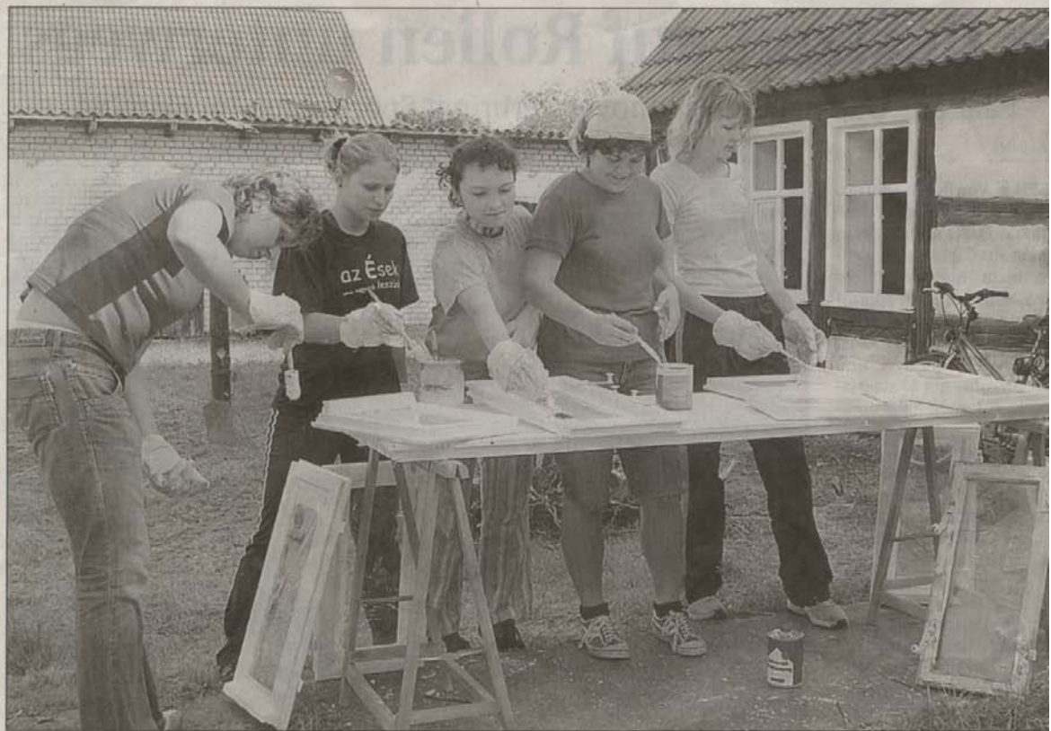
Jugendliche streichen Fenster am alten Gutsarbeiterhaus.
